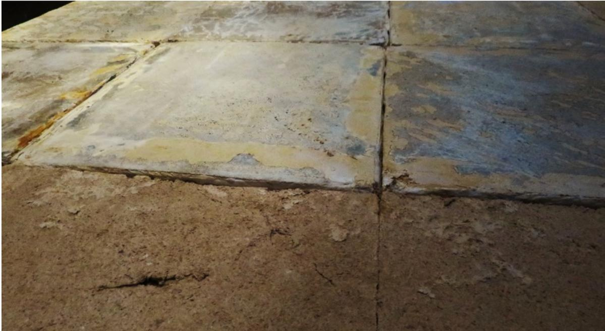
Abb 16: Bodenplatten im Stapferhaus: Starke Abnutzung unten, vermutlich neue Platten oben
