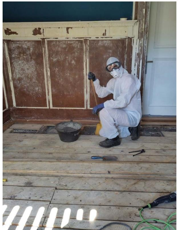
Bild 21: Ausbau der Schlacke
