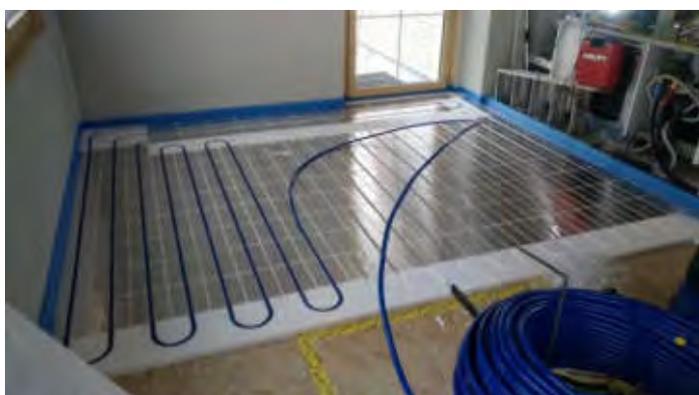
Abb. 8: Trockenbausystem mit EPS und Aluminium (Dünki Wärmetechnik GmbH, 2021)
