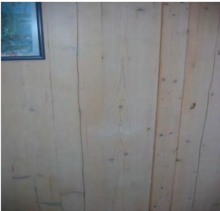
Abb. 9: Schadenbild zu Feuchtigkeit (Küng Holzbau AG, 2021)
