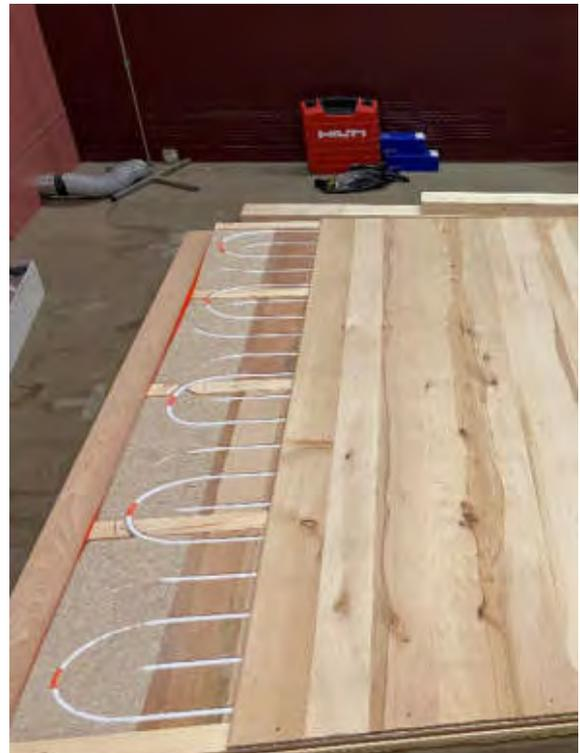
Abbildung 8: Verlegung Bodenbelag mit Schüttisolation
