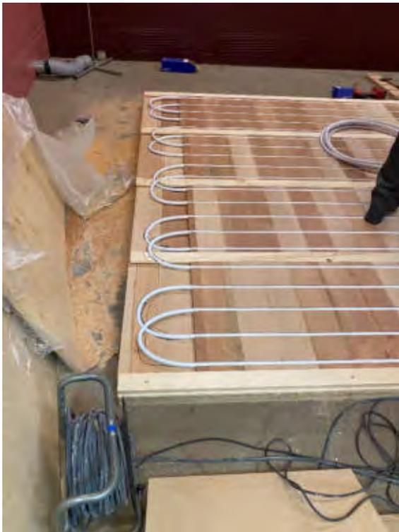
Abbildung 7: Verlegung Heizungsrohr
