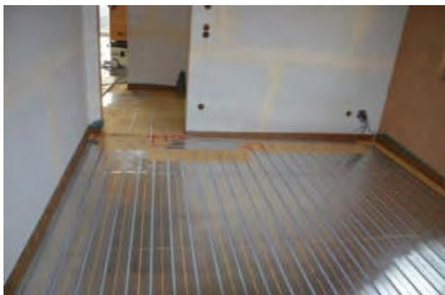
Abb. 7: Trockenbausystem mit Holzfaserplatte und Aluminium (Zimmerei & Holzbau Franz Wegmann GmbH, 2022)
