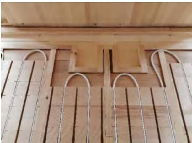
Abb. 2: LIGNOTHERM: Bodenheizungssystem aus Buchenholzbrettern (Küng Holzbau AG, 2021)
