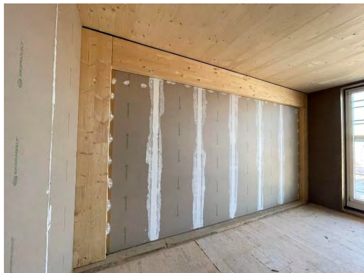
Abbildung 20 Strohbauplatten mit gespachtelten Fugen
