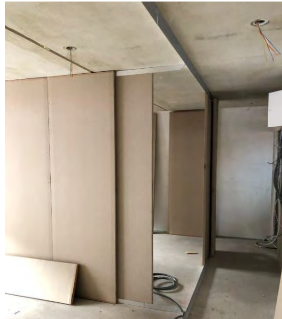
Abbildung 21 Raumhohe Strohbauplatten ohne Unterkonstruktion. Befestigung an Boden und Decke mit Winkelprofilen. Gut zu sehen ist der Versatz der vertikalen Plattenstöße der beiden Schichten
