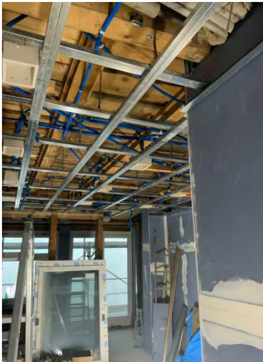
Abbildung 15 Unterkonstruktion der Decke mit Metallprofilen. Ausführung mit doppeltem Rost. Brandschutzboxen im Bereich der späteren Beleuchtung. Wände beplankt mit Hartgipsplatten
