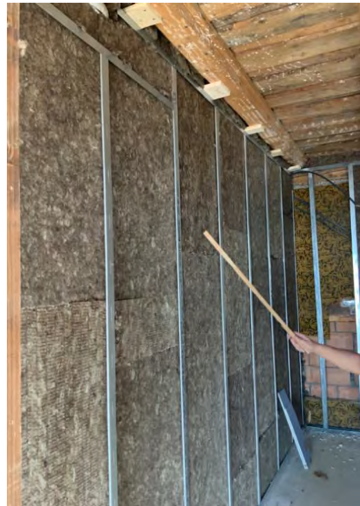
Abbildung 16 Vorne Unterkonstruktion der Trennwand mit Metallprofilen und Dämmung aus Steinwolle. Hinten Unterkonstruktion einer Vorsatzschale noch ohne Dämmung
