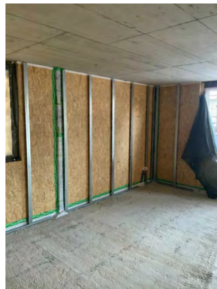
Abbildung 23 Unterkonstruktion an den Aussenwänden mit Metallprofilen
