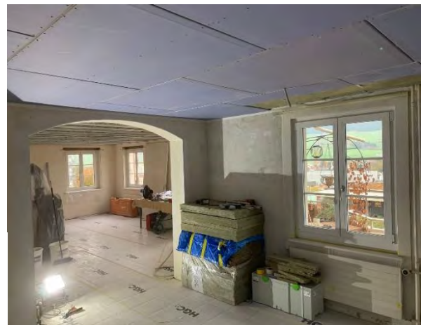
Abbildung 31 Beplankte Decke im Esszimmer. Die Platten mit den eingelegten Vorhangschienen sind noch nicht eingebaut und man sieht die Dämmung aus Steinwolle
