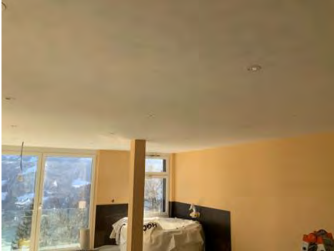
Abbildung 17 Fertige Oberflächen, Decke mit Glattputz und lasierendem Anstrich, Wände mit Kalkputz und deckendem Anstrich. Das Motto Safari wurde mit den Farbtönen, aber auch mit der Struktur des Wandverputzes und der späteren
