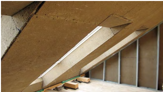
Abbildung 27 Hanf-Lehm Leichtbauplatten als Beplankung einer Dachschräge und im Hintergrund die erst einseitig beplankte Ständerwand
