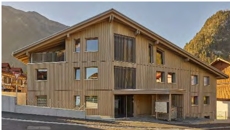
Abbildung 22 Eingangsfront des MFH in Wimmis mit der Holzfassade mit vertikaler Schalung und vorvergrauender Lasur
