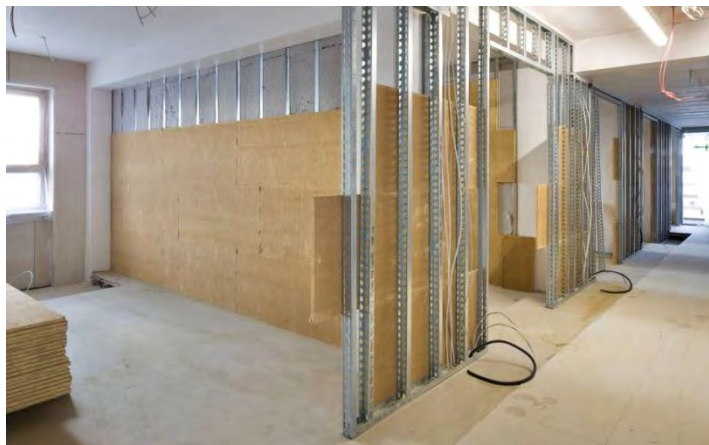
Abbildung 13 Lehmbauplatten auf Metallunterkonstruktion montiert
