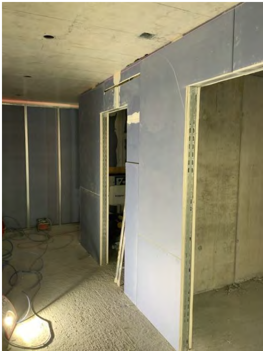
Abbildung 1 Trockenbauwände im Neubau Wohnhaus J44 in Interlaken. Kombination aus massiven Geschossdecken und Leichtbau für die Trennwände der Zimmer und Wohnungen
