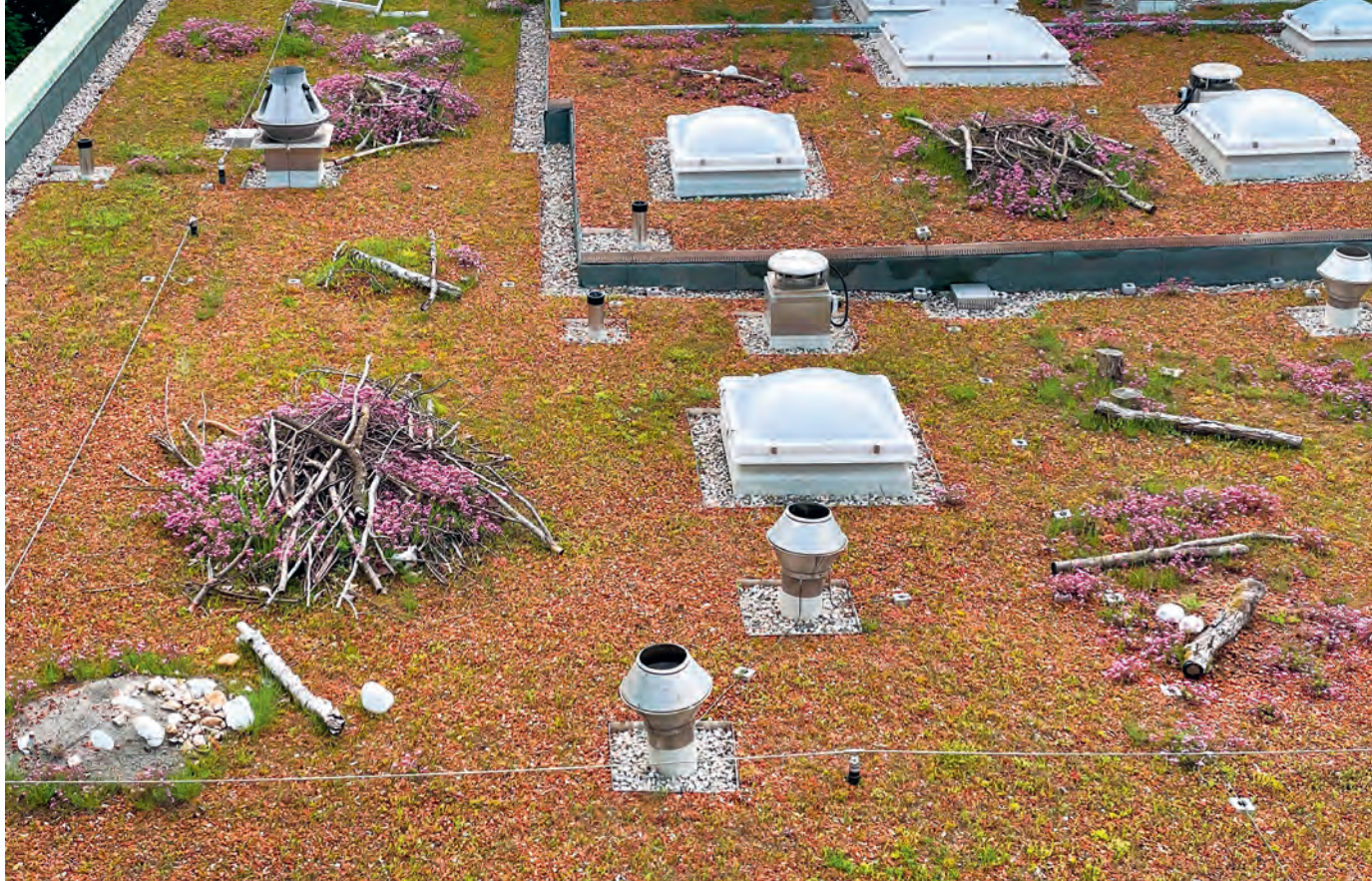
La toiture de la caserne des sapeurs-pompiers de Lausanne accueille une végétalisation extensive avec des tas de bois et de pierres.
