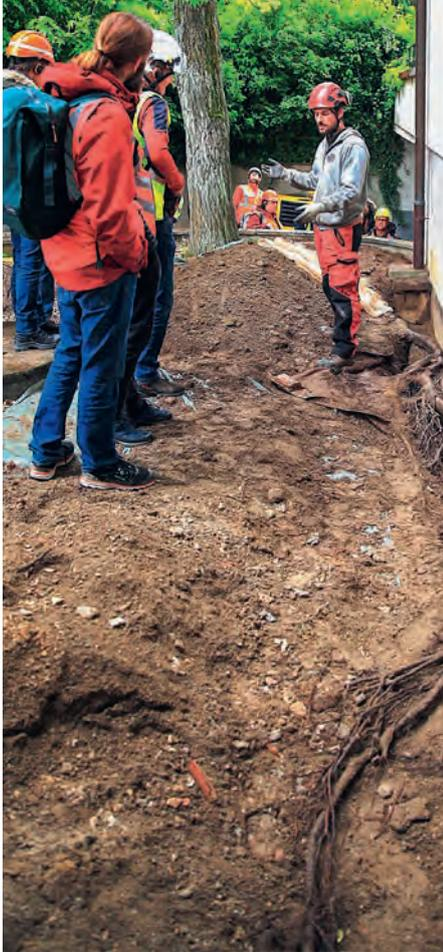
Mise à nue temporaire des racines principales d'un liquidambar à l'aide d'une lance à air comprimée, en vue de la pose d'une isolation périphérique de bâtiments. photo: Jean-Luc Pasquier
